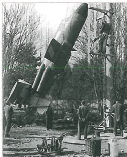
Natter under montering i startramp med starttraktererna på plats.
